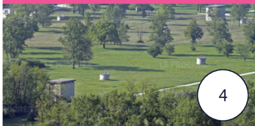
Zone de captage d'eau potable de Chasse-Ternay
