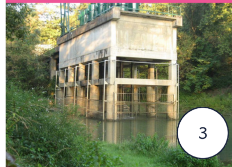
Station de pompage de Millery
